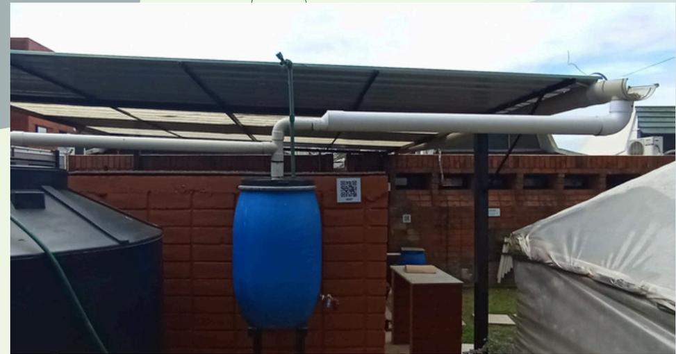
La tubería de P.V.C debe continuar de la canaleta que recibe el agua del techo, el cual debe tener una pendiente que permita el arrastre del agua y la suciedad cuando llueve
